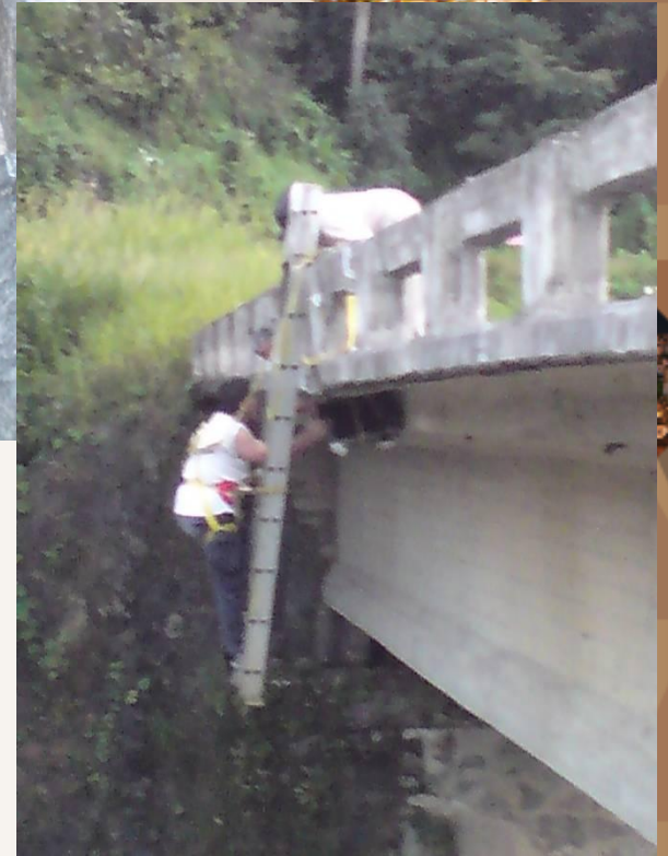
Instalación de la base del panel solar y gabinete de telemetría
