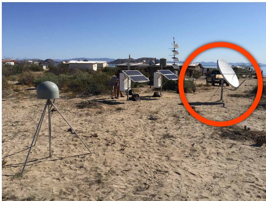
VSAT station in Bahia de los Angeles, BC.
